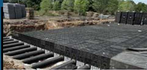
Depósitos de infiltración
